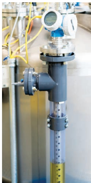
Obr. 5 Hladinometry Endress+Hauser Levelflex FMP55 boli namontované v obtoku separátora.
