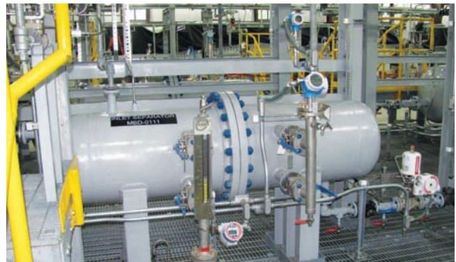
Obr. 2 Separátor ropy
