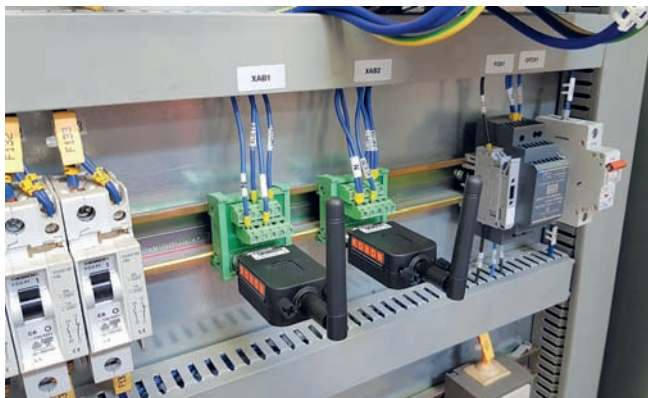
Umiestnenie FIOT Sensorov v rozvádzači
